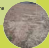
Paillage retenant le sol érodé
