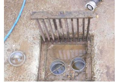
Un exutoire unique sur la dalle, relié à une vanne ou « guillotine » 3 voies (ou 2 vannes) permet de diriger manuellement les eaux souillées vers la cuve de stockage le procédé de traitement au moment du lavage.
