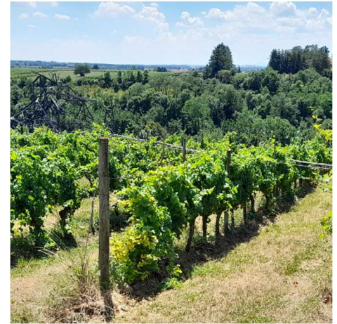
Pylône plié par la tempête et fils électriques dans les vignes à Saulcet (03).
