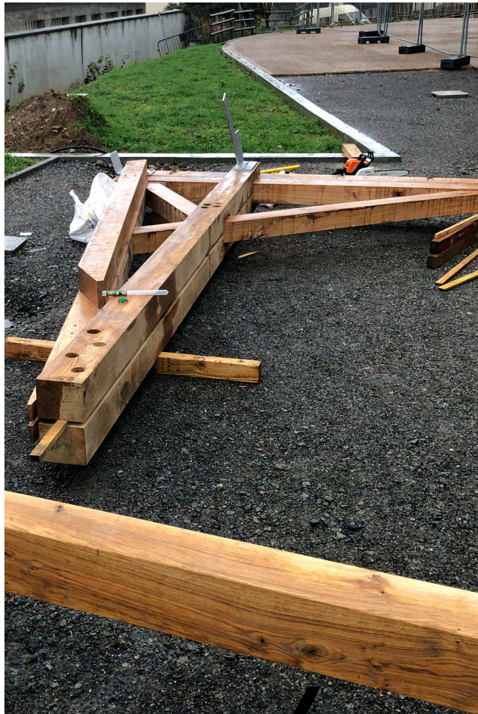
ASSEMBLAGE AU SOL
