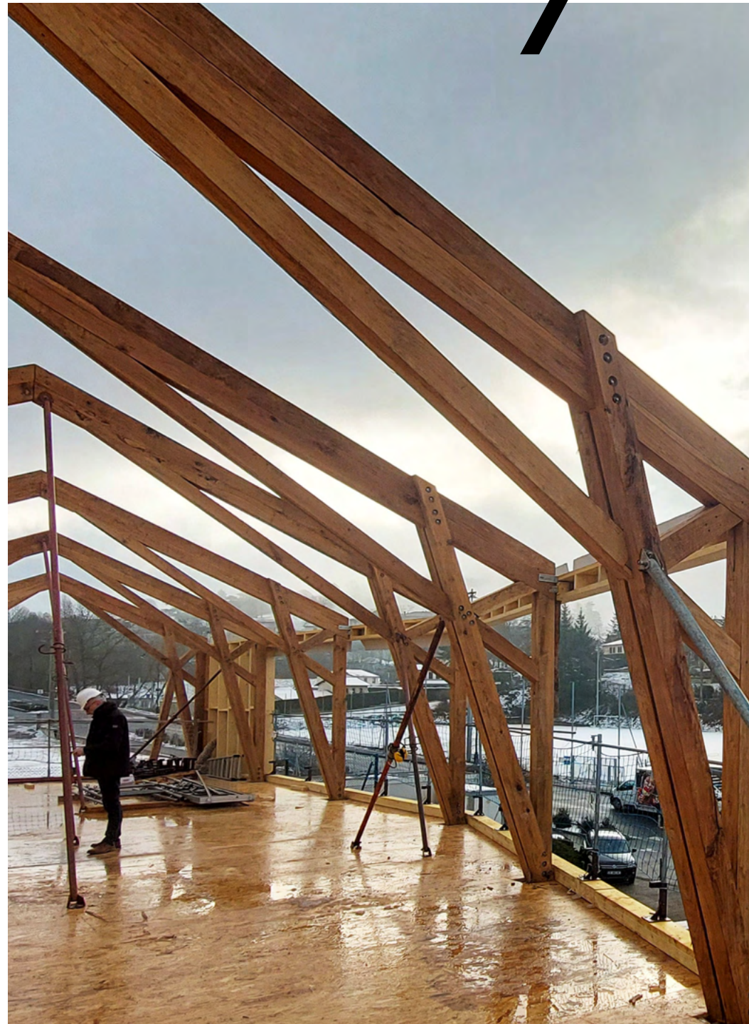
Photographie de chantier: Les portiques en chêne
